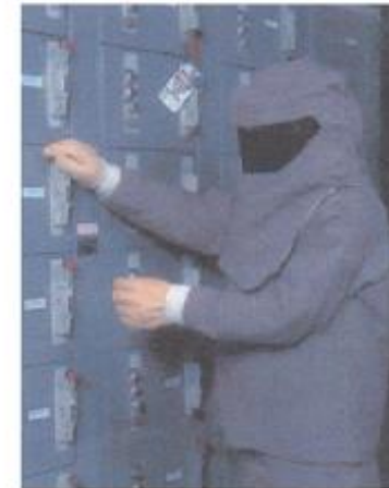
Ένδυση προστασίας έναντι τόξου κατά NFPA70 E, κατηγορία 4 (μέγιστη ασφάλεια)
